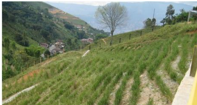
Ilustración 18: Estabilización mediante la siembra de pastos. Fuente: Internet.
