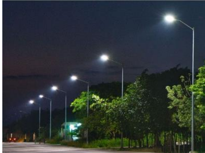
Ilustración 24: Iluminación Pública Solar. Fuente: internet.
