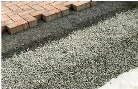
Ilustración 11: Detalle de pavimentos permeable. Fuente: sudsostenible.co
