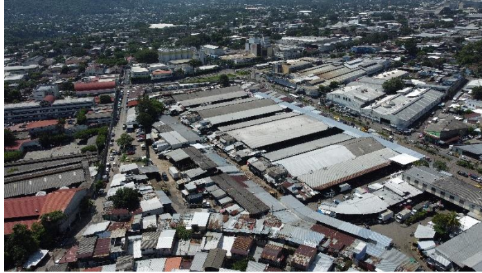
Ilustración 2. El desmantelamiento de la Tiendona no debe condicionar el éxito de otros objetivos. Fuente: Propia.
