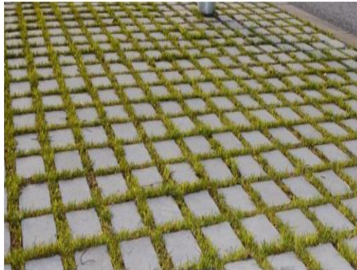
Ilustración 12:Detalle de pavimentos permeable. Fuente: www.breincocom.com
