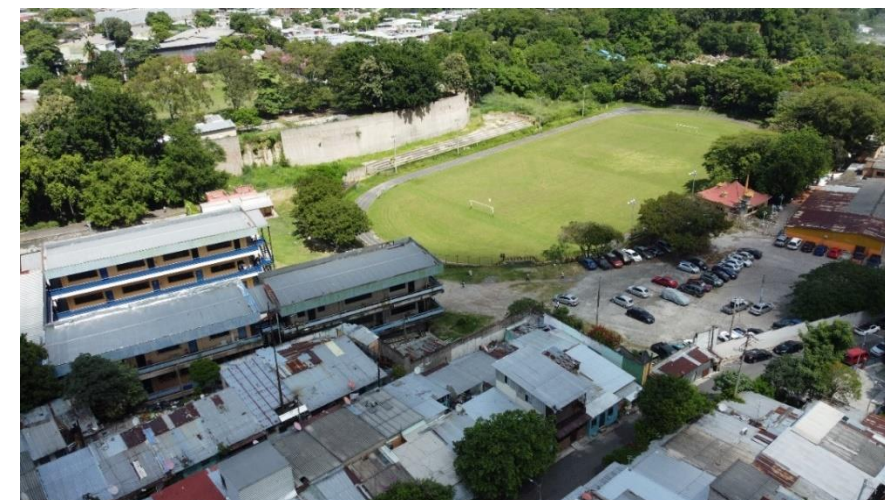
Cancha de atletismo y accesos con estacionamiento en el Polígono Don Bosco. Fuente: Propia
