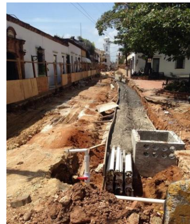
Renovación de calles en Ciudad Colonial de Santa Domingo (RD) con pavimento a nivel y soterramiento de infraestructura. Fuente: Propia.
